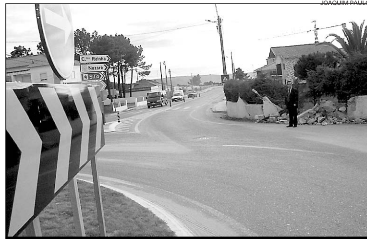
SINALIZAÇÃO PODERÁ EVITAR acidentes no local
